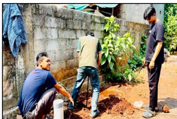
Gambar 7. Praktik Proses Penggalian Lubang Resapan Biopori
